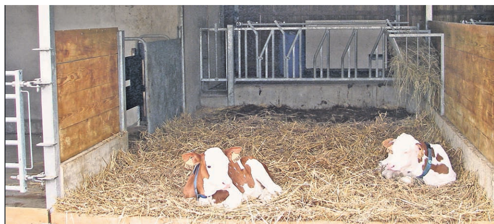
Le coût de la nursery avoisine les 60 000 euros tout compris : terrassement, bâtiment, caillebotis, DAL, bétons, électricité, eau... Longueur : 20 m, largeur : 8 m, caillebotis : 3 m
