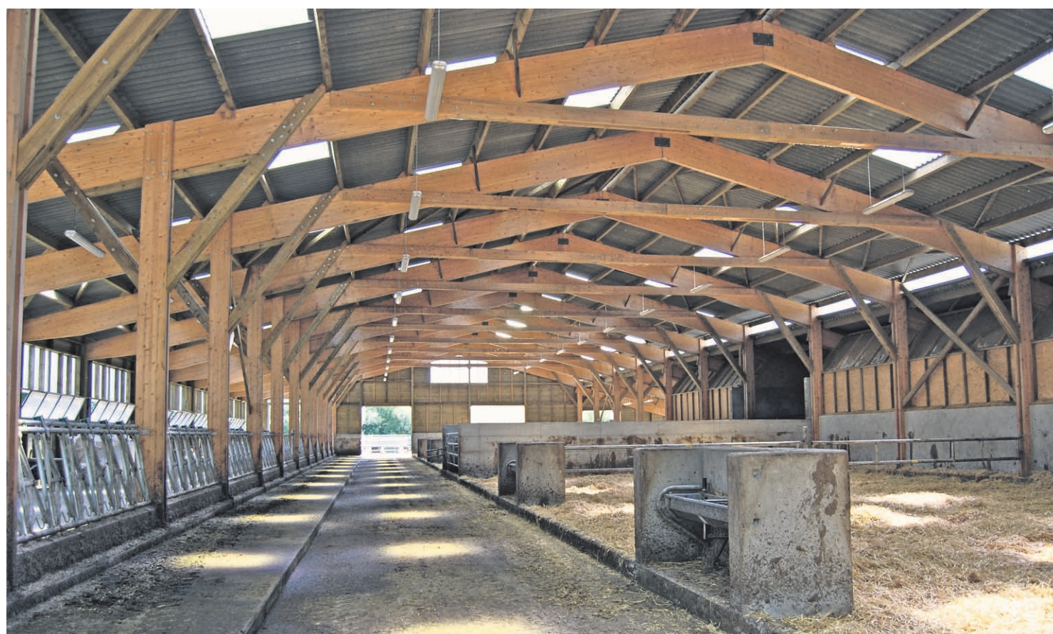
Que d'espace et de lumière ! Le confort des éleveurs n'est pas oublié : le paillage et le raclage (marche comprise) s'effectuent au tracteur
